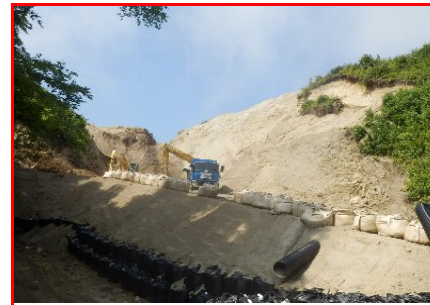
③施工：刈屋建設
