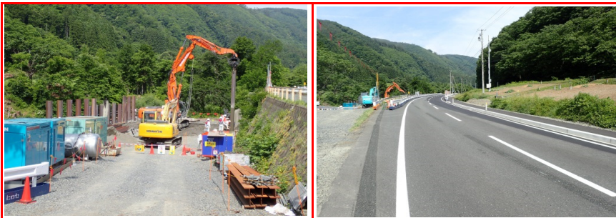
⑦施工：安藤・間
